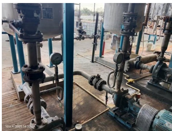
รูปที่ 2-43 ติดตั้ง Pressure และ Temperature Transmitter ที่ระบบการกลั่น
