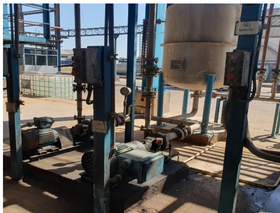
รูปที่ 2-51 Boiler Feed Water Pump
