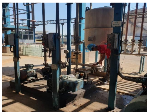
รูปที่ 2-47 เจ้าหน้าที่ตรวจสอบ สภาพถัง ระบบท่อ ข้อต่อ และวาล์ว
