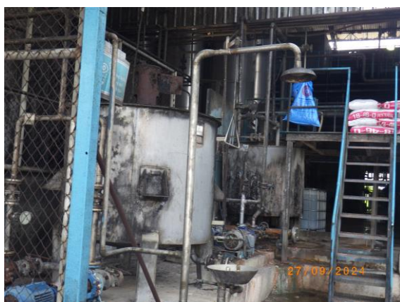
รูปที่ 2-35 ติดตั้งที่ล้างตา / ฝักบัวฉุกเฉิน
