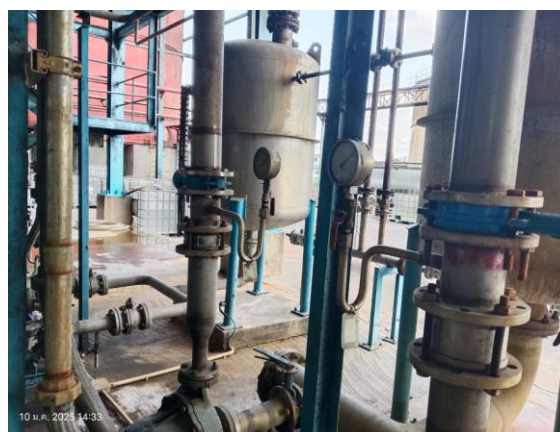
รูปที่ 2-43 ติดตั้ง Pressure และ Temperature Transmitter ที่ระบบการกลั่น
