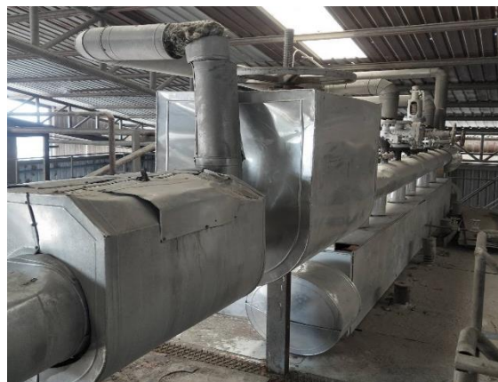
รูปที่ 2-52 ล้นจ่ายไอน้ำ (Main Steam Valve)
