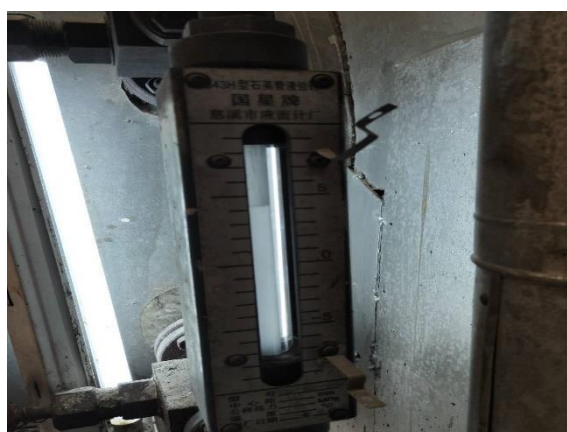
รูปที่ 2-49 เครื่องวัดระดับน้ำชนิดหลอดแก้ว
